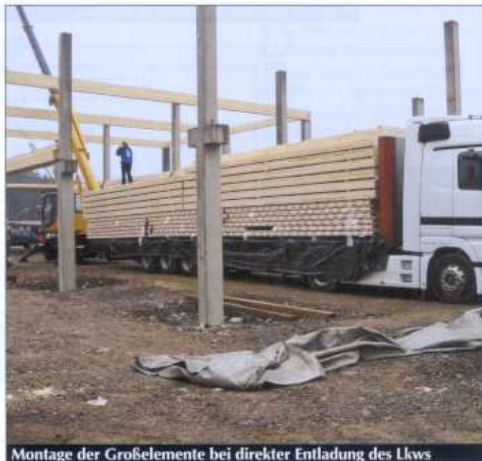
Montage der Großelemente bei direkter Entladung des Lkws
