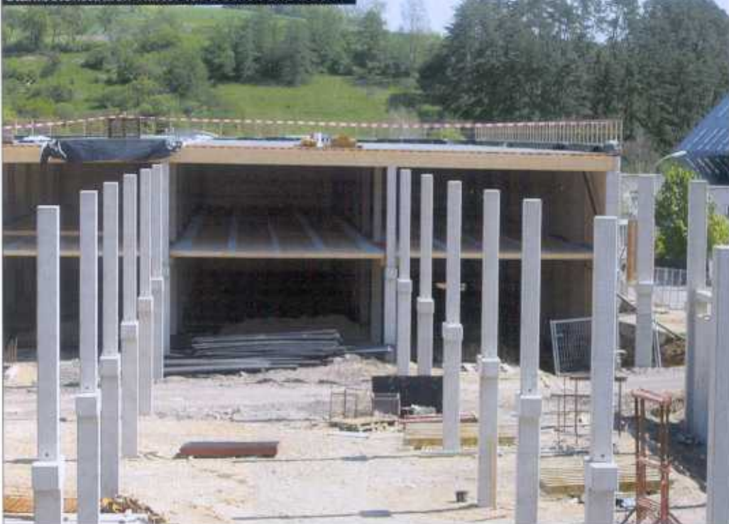
Stahlbetonstützen-Raster für Decken und Dach
