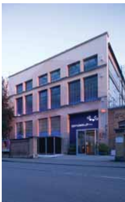
Bild 1. „Blinde Kuh“ – Restaurant in einem massiv hölzernen Kubus in einer umgenutzten Fabrikhalle
