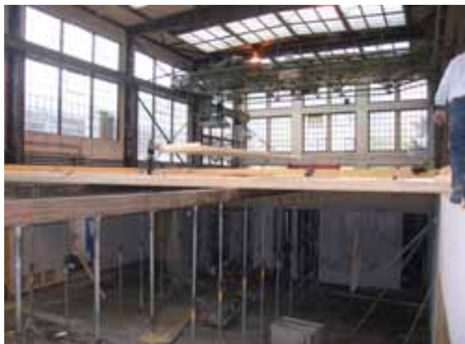
Bilder 3 und 4. Einbau der HBV-Decke
